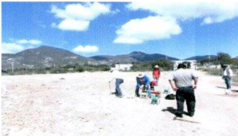
PERFORACIÓN EXPLORATORIA A 140 MTS. DE PROFUNDIDAD
