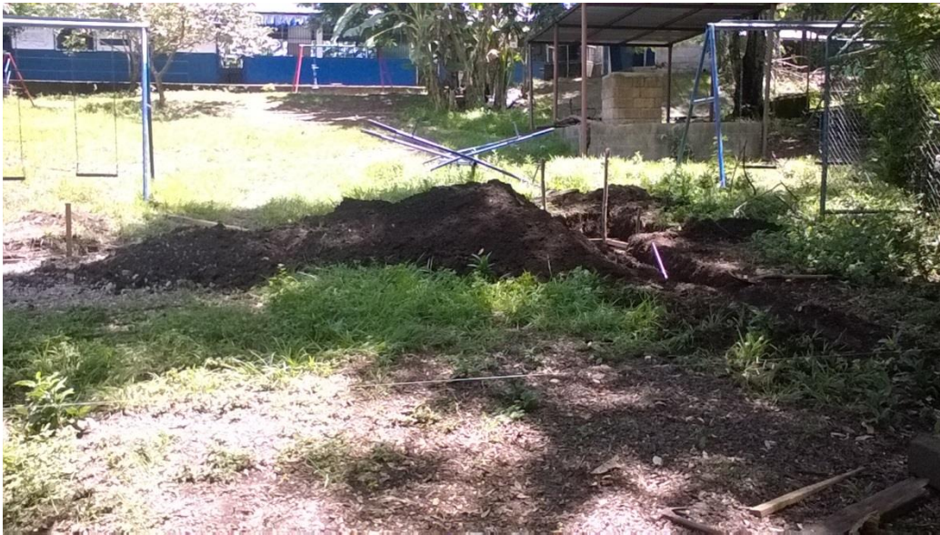
Foto 3. Construcción de infraestructura Huerto Escolar Juan Diego
