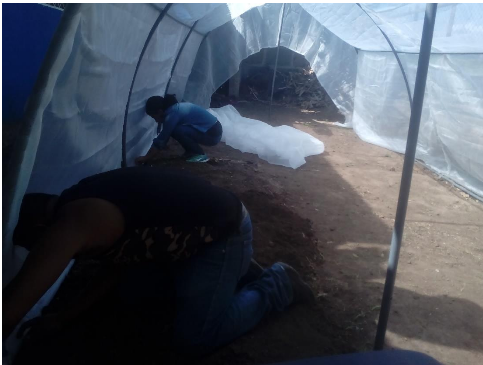
Foto 26. Construcción de Micro-túnel
