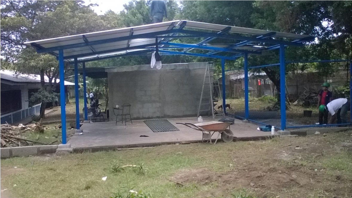
Foto 1. Construcción de infraestructura de Huerto Escolar. Colegio Epifanía
