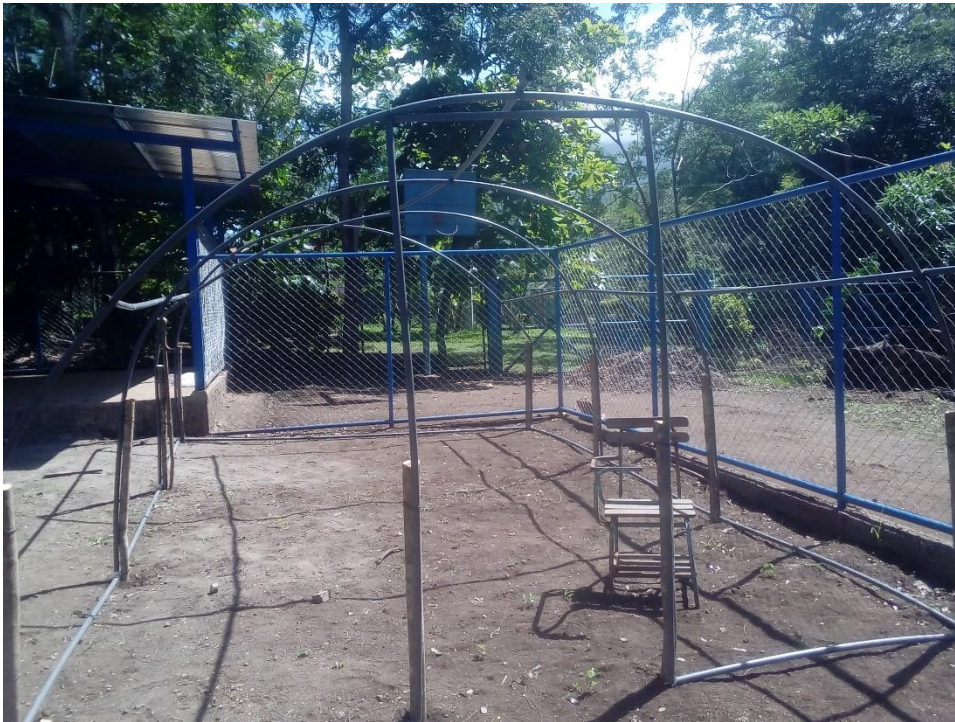
Foto 25. Construcción de microtuneles
