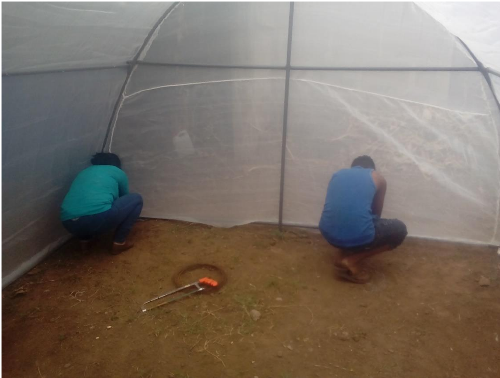
Foto 27. Construcción de Micro-túnel
