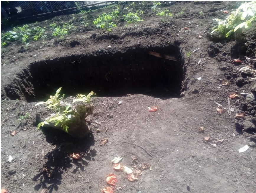
Foto 12. Construcción de compostera
